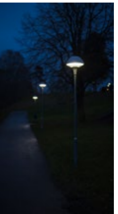
Många nya gatlampor har satts upp – och de som redan fanns på plats har fått ny ledbelysning som lyser bättre.
