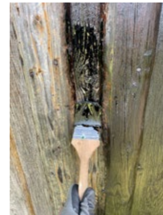
Att tjära fasaden är en gammal metod.
